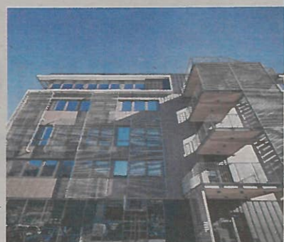
▲ Ce bâtiment tertiaire sur 5 niveaux dispose de nombreuses innovations techniques qui offrent des performances énergétiques de premier ordre : façade rideau avec vitrages athermiques, isolation renforcée...
