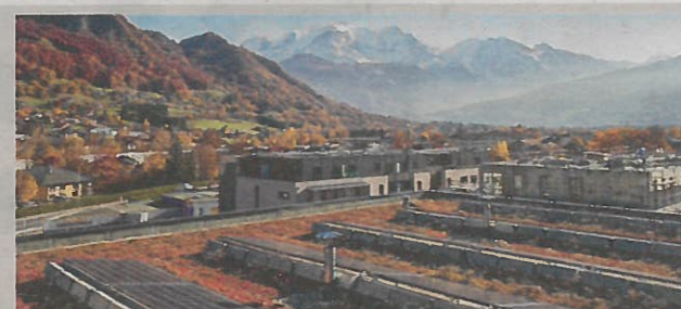
▲ Des panneaux photovoltaïques ont été installés sur le toit du bâtiment pour produire une électricité utilisée en autoconsommation. Une façon efficace et économique d'alimenter les éclairages et le matériel informatique des bureaux.
