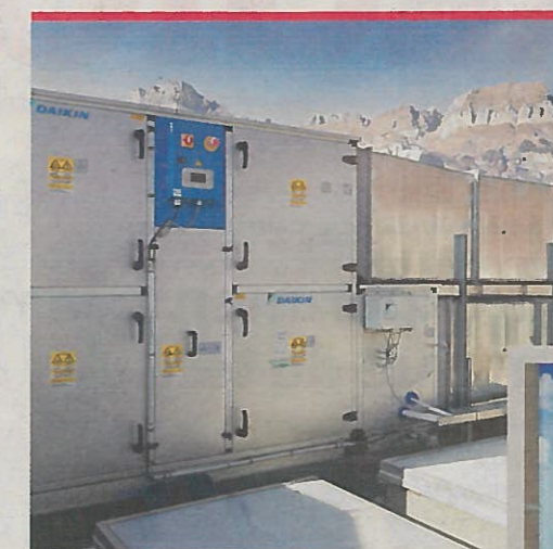
▲ Comme son nom l'indique, la centrale de traitement d'air Modular permet d'adapter facilement le dimensionnement de l'installation aux contraintes de chaque chantier. Elle garantit une qualité d'air optimale grâce à son module principal avec système de récupération de chaleur équipé de la régulation MicroTech III, de ses ventilateurs EC et de ses filtres.
