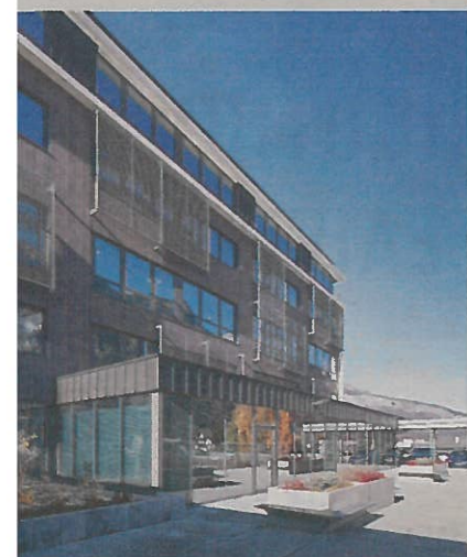
▲ Ce bâtiment tertiaire sur 5 niveaux dispose de nombreuses innovations techniques qui offrent des performances énergétiques de premier ordre : façade rideau avec vitrages athermiques, isolation renforcée...
