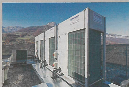
▲ La récupération d'énergie permet un chauffage et un rafraîchissement simultanés. Cette technologie est idéalement adaptée aux hôtels car elle permet aux clients de réguler leur propre confort et est également précieuse pour les bâtiments avec des bureaux orientés vers le nord et d'autres vers le sud.
